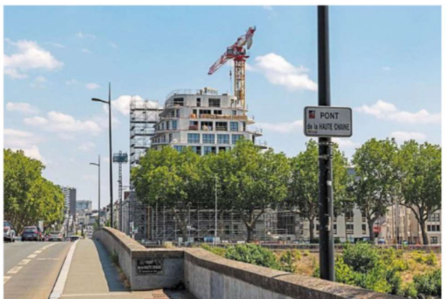
La grue sera démontée le mois prochain mais la résidence ne sera livrée qu'au premier trimestre 2024.
